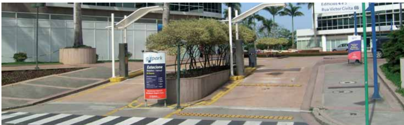
Entrada do estacionamento da gEpark no Rio Office Park
